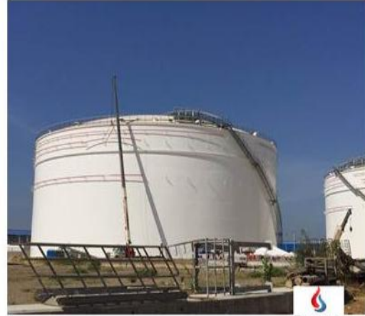
TANQUE DE ALMACENAMIENTO DE CRUDO ( \varnothing 55.47 x 21.94 Mts) CON VOLUMEN DE 330.000 bls c/u, ubicada en Cartagena Colombia
