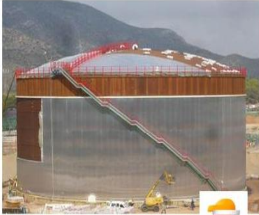
TANQUE DE ALMACENAMIENTO RESIDUO DE VACIO ( \varnothing 46 x 20 Mts- 33238 M 3 ), localidad de Cartagena España
