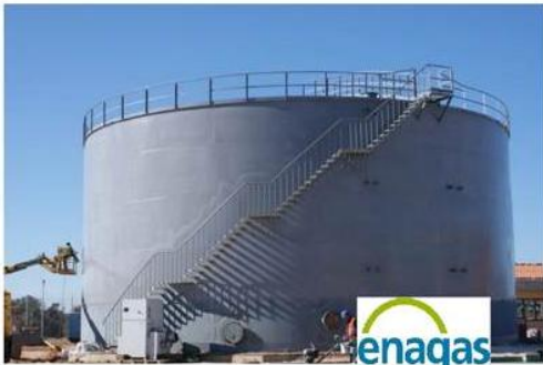
TANQUE DE ALMACENAMIENTO DE AGUA ( \varnothing 20.5 x 9.5 Mts) I.A GAS YELA- GUADALAJARA.
