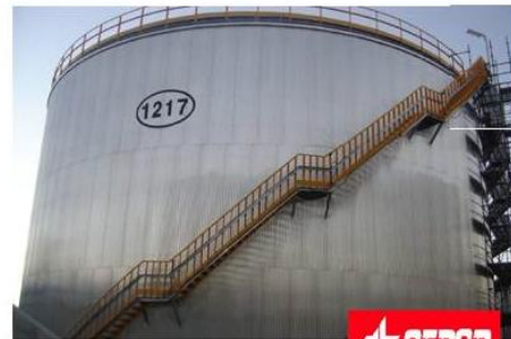
TANQUE DE ALMACENAMIENTO DE GAS OIL ( \varnothing 24 x 12 Mts) REFINERIA ALGECIRAS.
